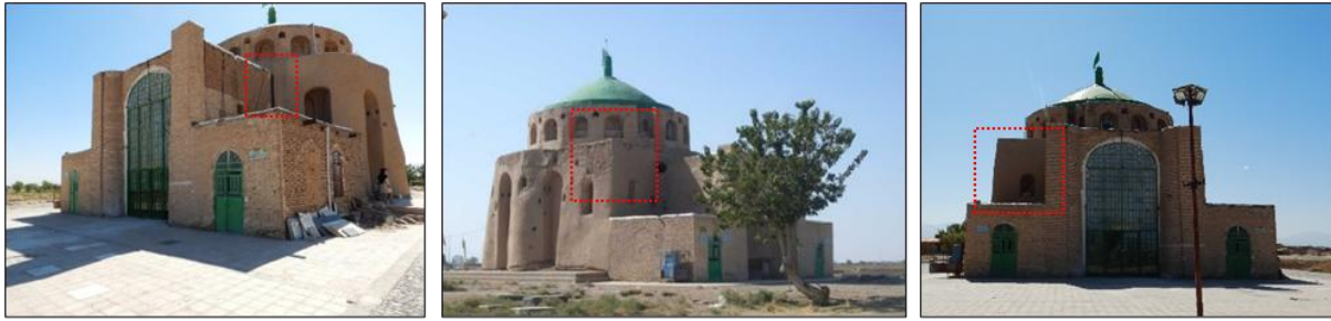
شکل ۲. آرامگاه هفت‌تن؛ راست: برونزد دیوار پشتیبان یا ایوان اول؛ وسط: تغییر شکل هشت ضلعی آرامگاه بواسطه احداث دیوار؛ چپ: شکاف بین دو ایوان احداثی.
