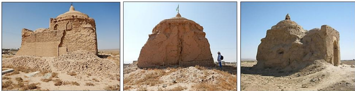
شکل ۷. امامزاده قاسم؛ راست: دید از جهت جنوب غربی؛ وسط: دید از جهت شمال؛ چپ: دید از جهت شرق با شواهد دو مرحله دیوار مرمتی و درگاه مسدود شده در فاز اول.
