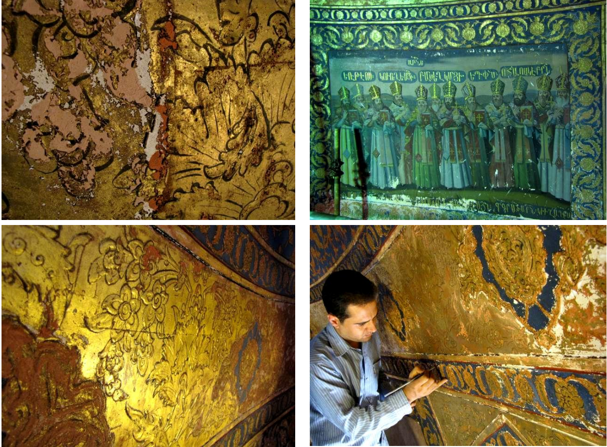
شکل ۵. آرایه‌های لایه‌چینی و طلاچسبانی گنبد خانهٔ کلیسای بیت‌لحم.
