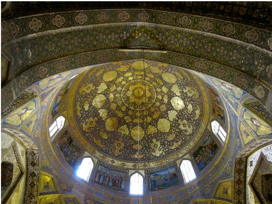
شکل ۶. آرایه‌های لایه‌چینی و طلاچسبانی گنبد خانهٔ کلیسای بیت‌لحم.
