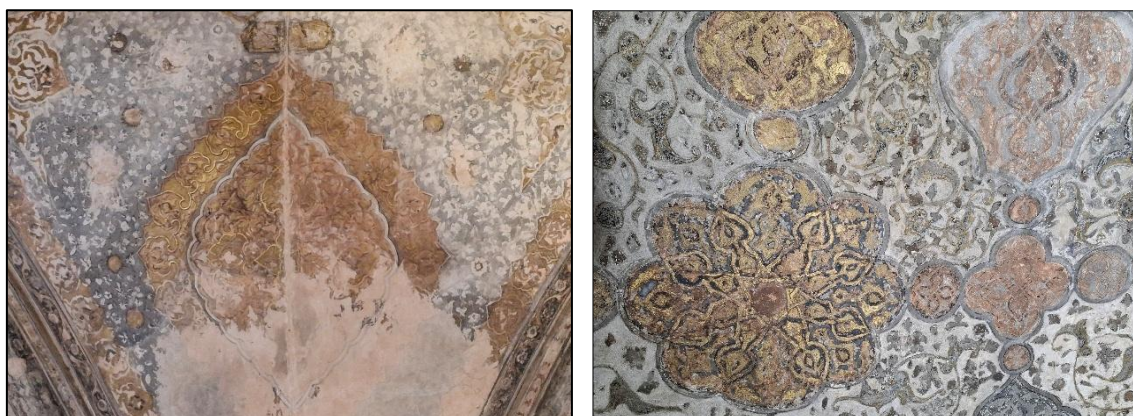
شکل ۱۲. راست: آرایه‌های لایه‌چینی طلاچسبانی شده در سقف گنبد مقبره خواجه یوسف، مدرسه دو در مجموعه حرم رضوی مشهد. چپ: آرایه‌های لایه‌چینی طلاچسبانی شده در قسمت کاربندی گنبدخانه مسجد شاه مشهد.
