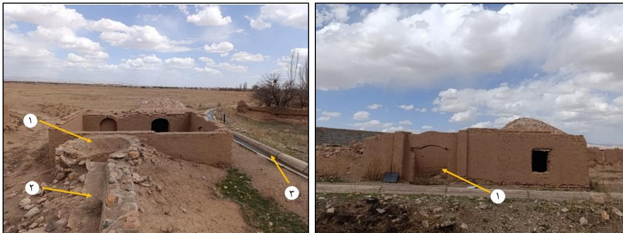
شکل ۷: جبهه جنوبی آسیاب: (۱) ورودی اصلی (تاریخ عکس، سال ۱۴۰۳)
