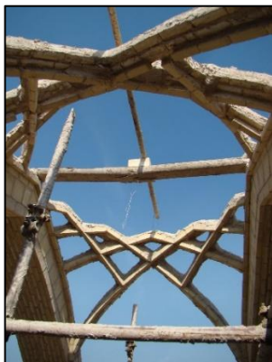
شکل ۳۵: استفاده از چوب و ریسمان برای کنترل تراز بودن افقی تیزه‌های قالب‌ها- بازار بید آباد اصفهان (منبع: آرشیو میراث فرهنگی اصفهان)
