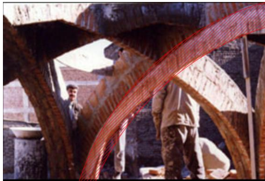
شکل ۱۷: استفاده از قالب چوبی در ساخت لنگه (عکاس: آئینه‌چی، ۱۳۹۰)
