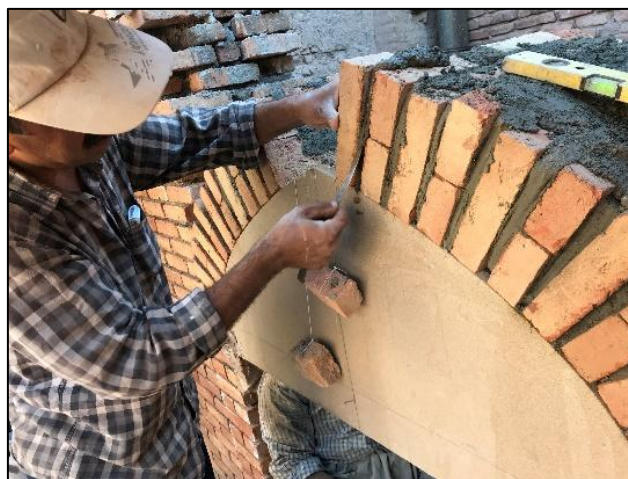
شکل ۲۶: استفاده از میخ و ریسمان برای کنترل تراز بودن رج افقی آجرها (عکاس: آئینه‌چی، ۱۳۹۹)
