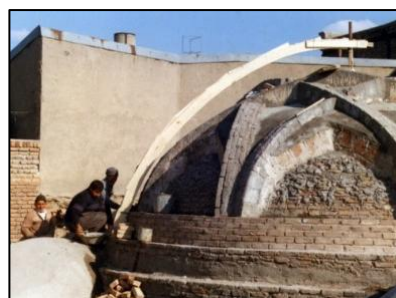
شکل ۲۰-الف: استفاده از شابلون چوبی جهت اجرای عرقچین (حمام نوبر تبریز)
