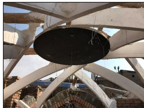
شکل ۳۴: نحوه تکیه دادن لنگه‌های گچی به نه‌نین (عکاس: آئینه‌چی، ۱۳۹۸)
