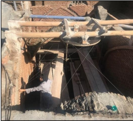
شکل ۳۱: شیوه اجرای نه‌نین و نحوه یافتن امتداد ریسمان روی تویزه با شاغول
