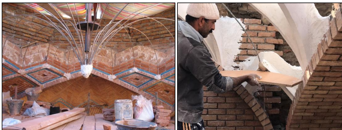
شکل ۳۶: استفاده از میلگرد جهت چینش آجرهای پرکننده پاباریک (تیمچه میرزا جلیل بازار تبریز) (منبع: آئینه‌چی، ۱۳۹۷)
