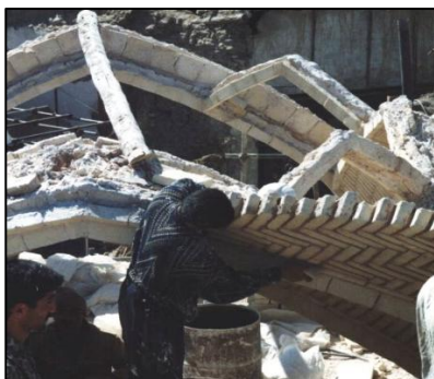
شکل ۱۱: نقوش آجری خفته راسته در عناصر کاربردی (بازار اصفهان) (منبع: آرشیو میراث فرهنگی اصفهان)
