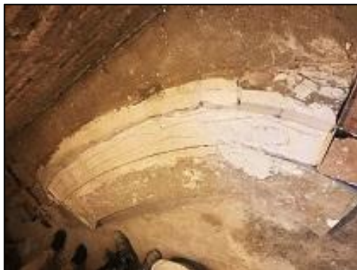
شکل ۱۹: نحوه ساخت قالب گچی
