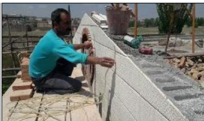
شکل ۲۱: استفاده از شیلنگ تراز برای کنترل تراز بودن افقی (عکاس: آئینه چی، ۱۳۹۶)
