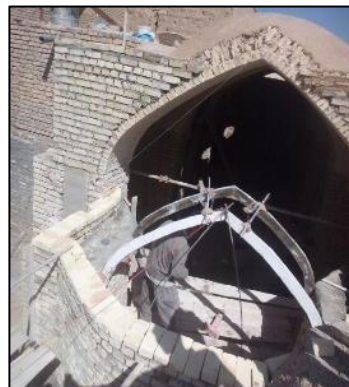
شکل ۱۸: قالب های بسته شده برای محراب برای تویزه توسط محمد پاکنژاد
