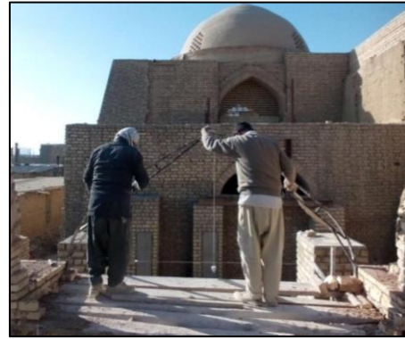
شکل ۲۳: نحوه شاغول کردن قالب توسط پاکنژاد (عکاس: آئینه‌چی، ۱۳۹۹)
